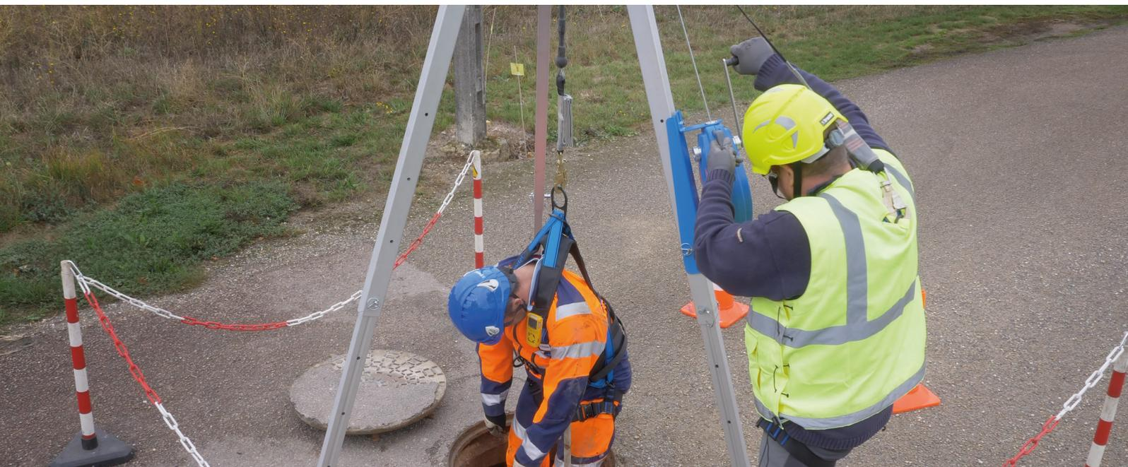
在密闭空间内工作总是需要使用防坠落装置。Tractel建议使用Blocfor ESD自伸缩速差器进行坠落保护。还建议采用救援方案，可由经认证的EN1496B Carol R绞盘提供，也可直接使用Blocfor R ESD，通过其集成的垂直救援绞盘将自伸缩救生索与救援功能相结合。
